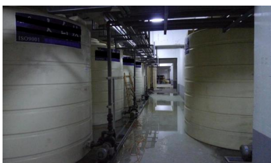
图5 地下室废水收集槽
